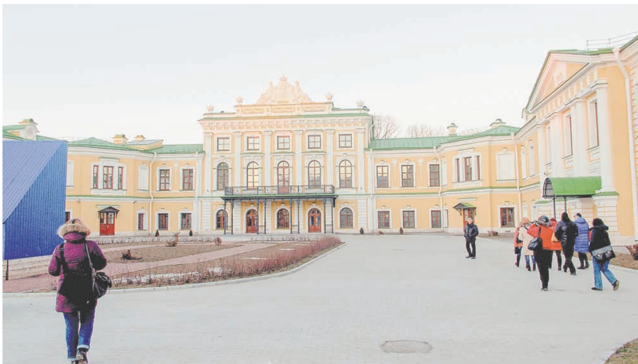
Комплексная реставрация дворца, некогда предназначавшегося для отдыха императорской семьи по пути из Петербурга в Москву, началась в 2012 году. Сегодня работы практически завершены
