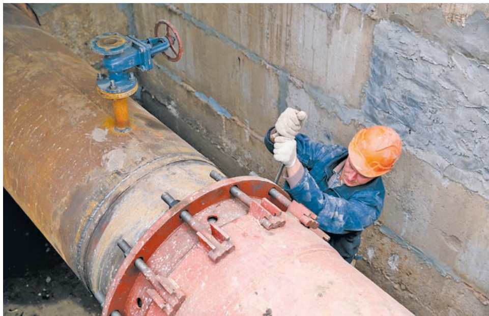
Фото: архив «Тверских ведомостей»
