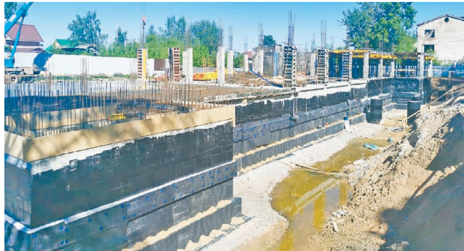
Строительство детских поликлиник в Кимрах идет полным ходом
