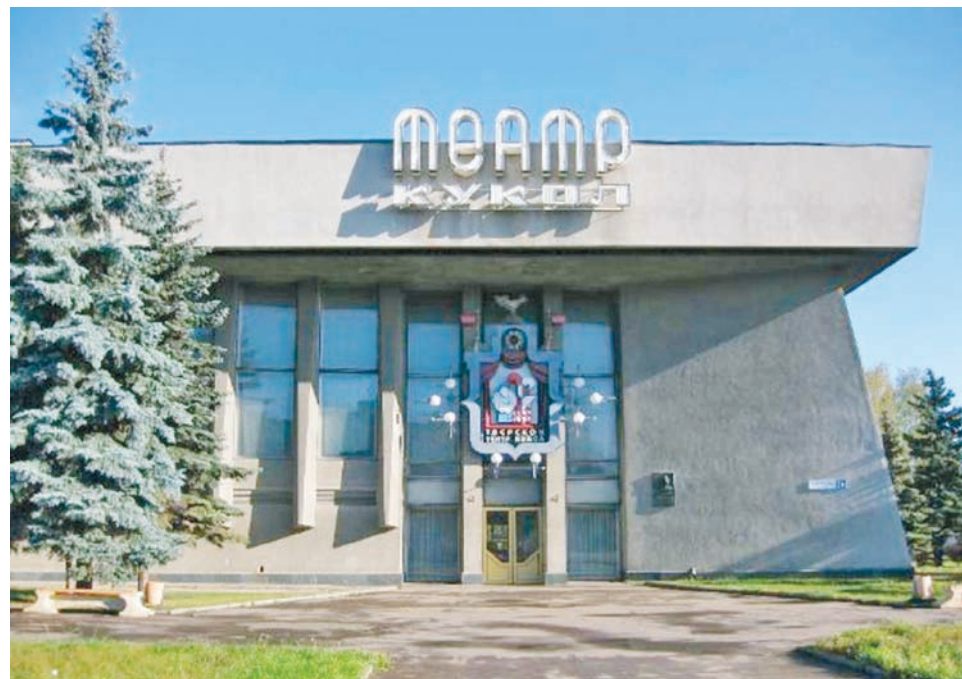
Фото: архив «Тверских ведомостей»
