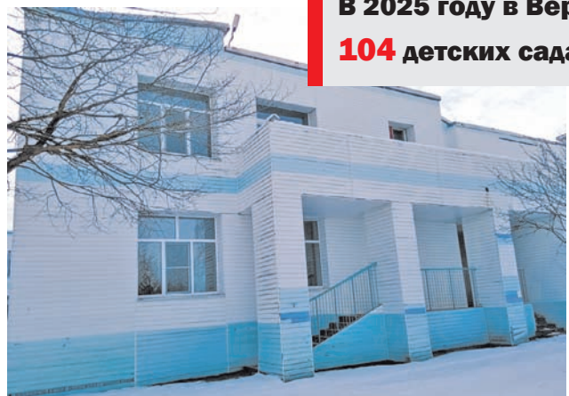
Детский сад «Малыш» в Удомле ждет масштабный ремонт
