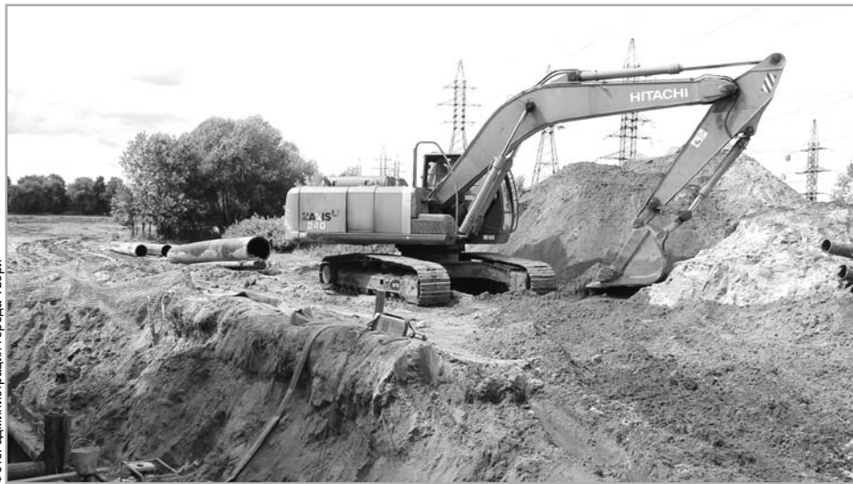
Благодаря консолидации активов ЖКХ решаются застарелые проблемы отрасли. В муниципалитетах меняют километры труб, строят новые водоводы, реконструируют очистные
