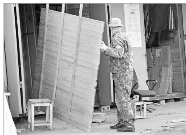
Часть боксов и контейнеров, где ранее осуществлялась незаконная торговля, уже снесены и вывезены
