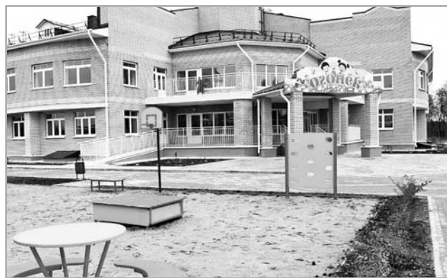
Детский сад полностью готов открыть свои двери для детей: завершены общестроительные работы, проведены наружные и внутренние инженерные сети, выполнены отделочные работы, закуплено и установлено оборудование
