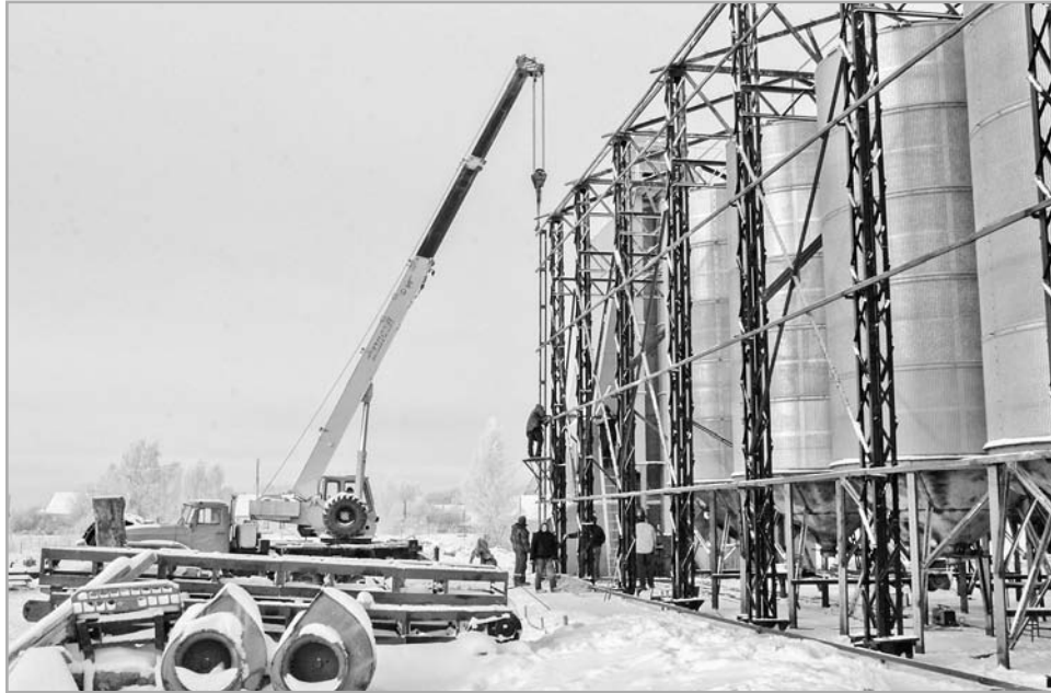
К лету завершится строительство зерносушильно-сортировального комплекса мощностью до 10 тысяч тонн зерна
