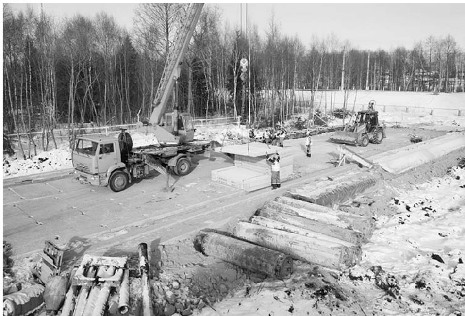
Устройство временной подъездной дороги со стороны стартового котлована
