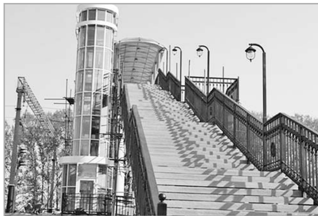
Строительство надземного железнодорожного перехода в Твери – это тоже старый проект, который наконец воплотится
