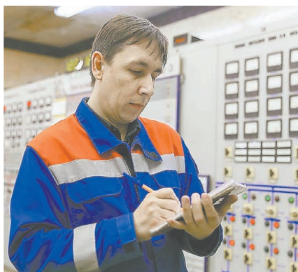
В главной части теплоэлектроцентрали круглосуточно следят за обстановкой на сетях
