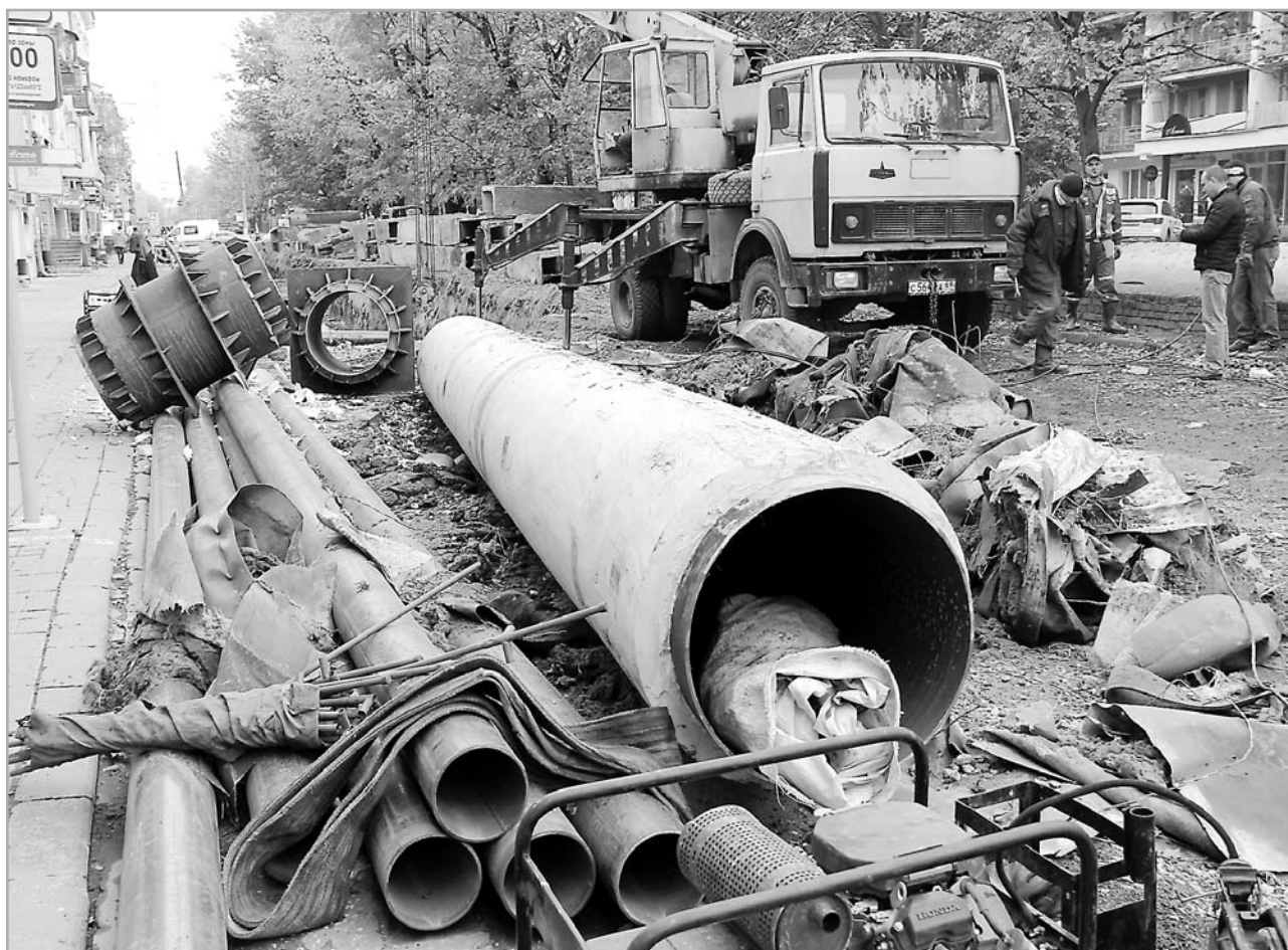
Начало отопительного сезона-2017 не остановило плановых работ по реконструкции систем теплоснабжения. В дома, которые находятся в зоне масштабного ремонта теплосетей, отопление подается по резервным схемам
