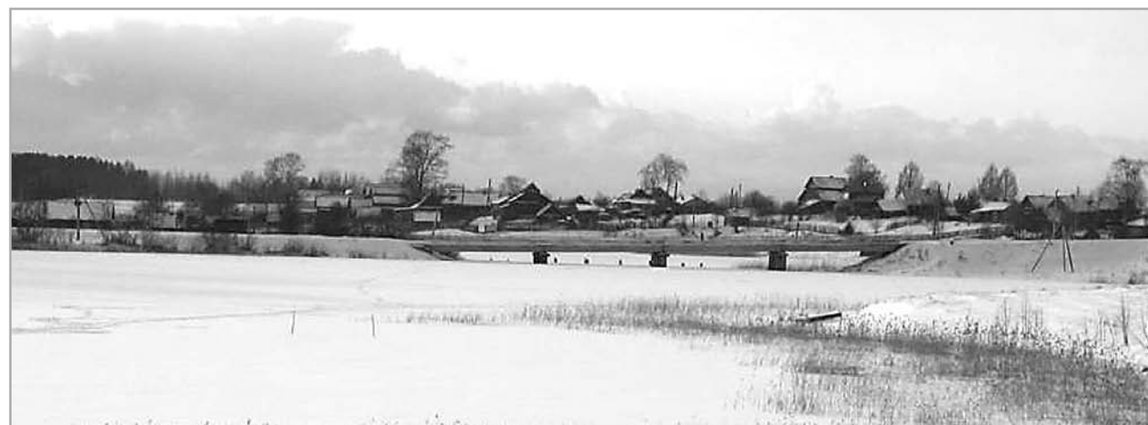
Этот мост соединяет деревни Сорога и Покровское
