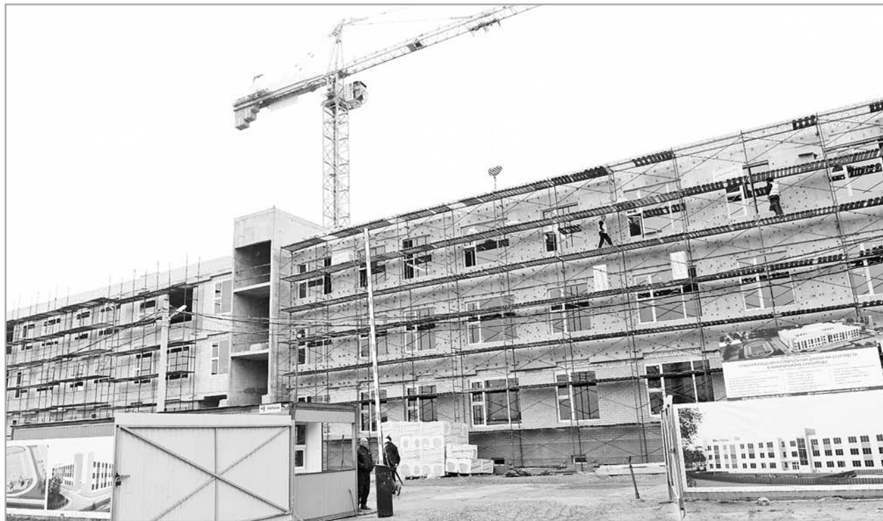
В микрорайоне Брусилово ведется строительство новой школы на 1224 места
