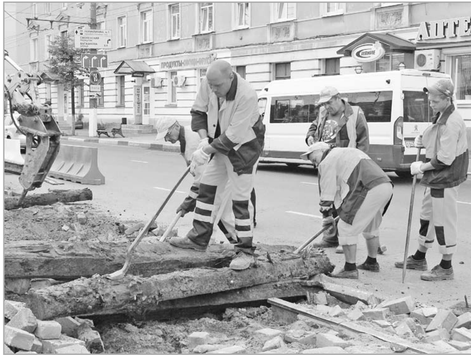
Столичные бригады активно ведут демонтаж трамвайных рельсов и шпал
