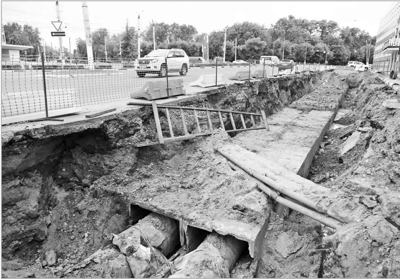
Реальная картина с ремонтом теплосетей в Твери резко расходится с обещаниями «Тверской генерации»
