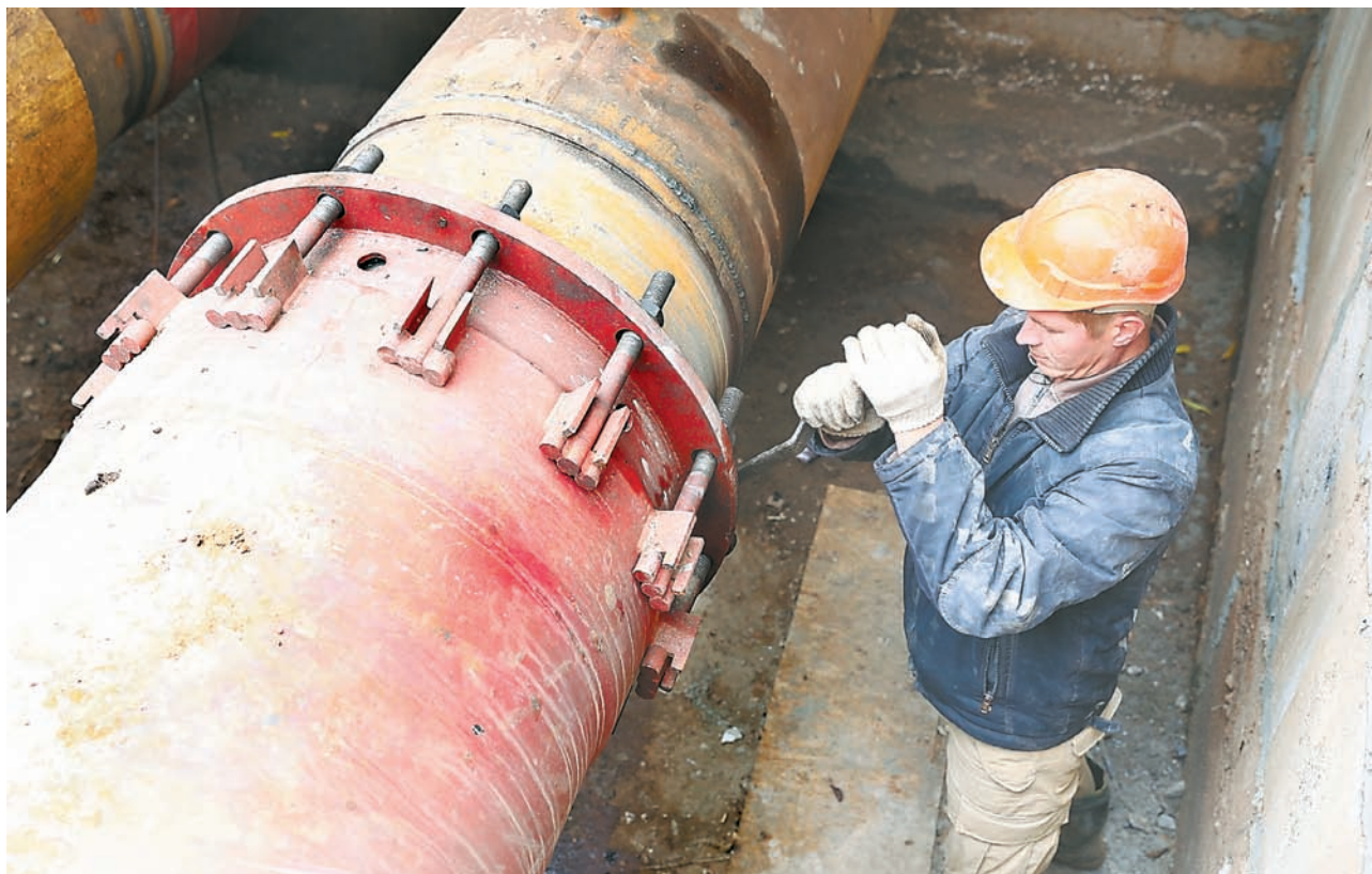
Традиционная картина последних недель – разрытые теплотрассы в Твери – в последние дни наконец-то добавились работающими на них ремонтниками
