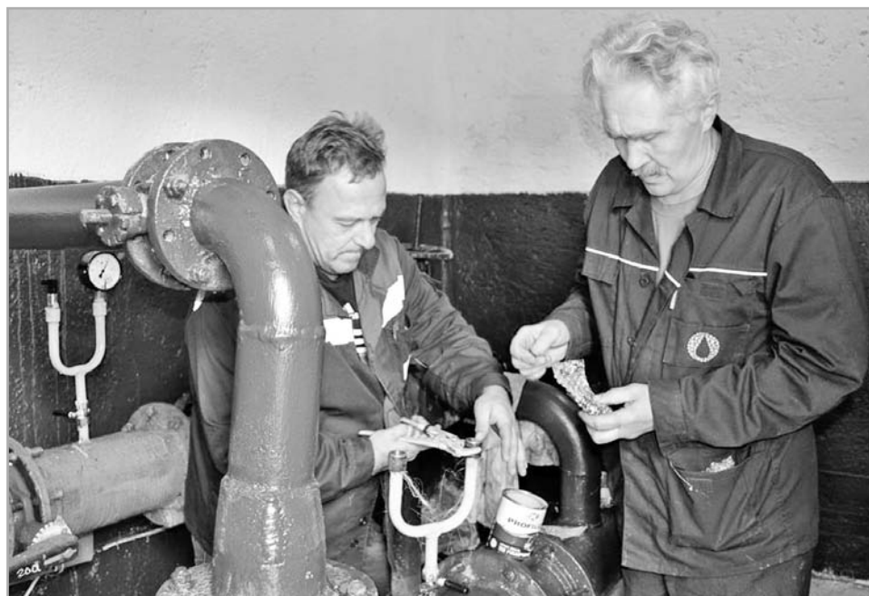
Специалисты устанавливают датчики давления на скважинах
