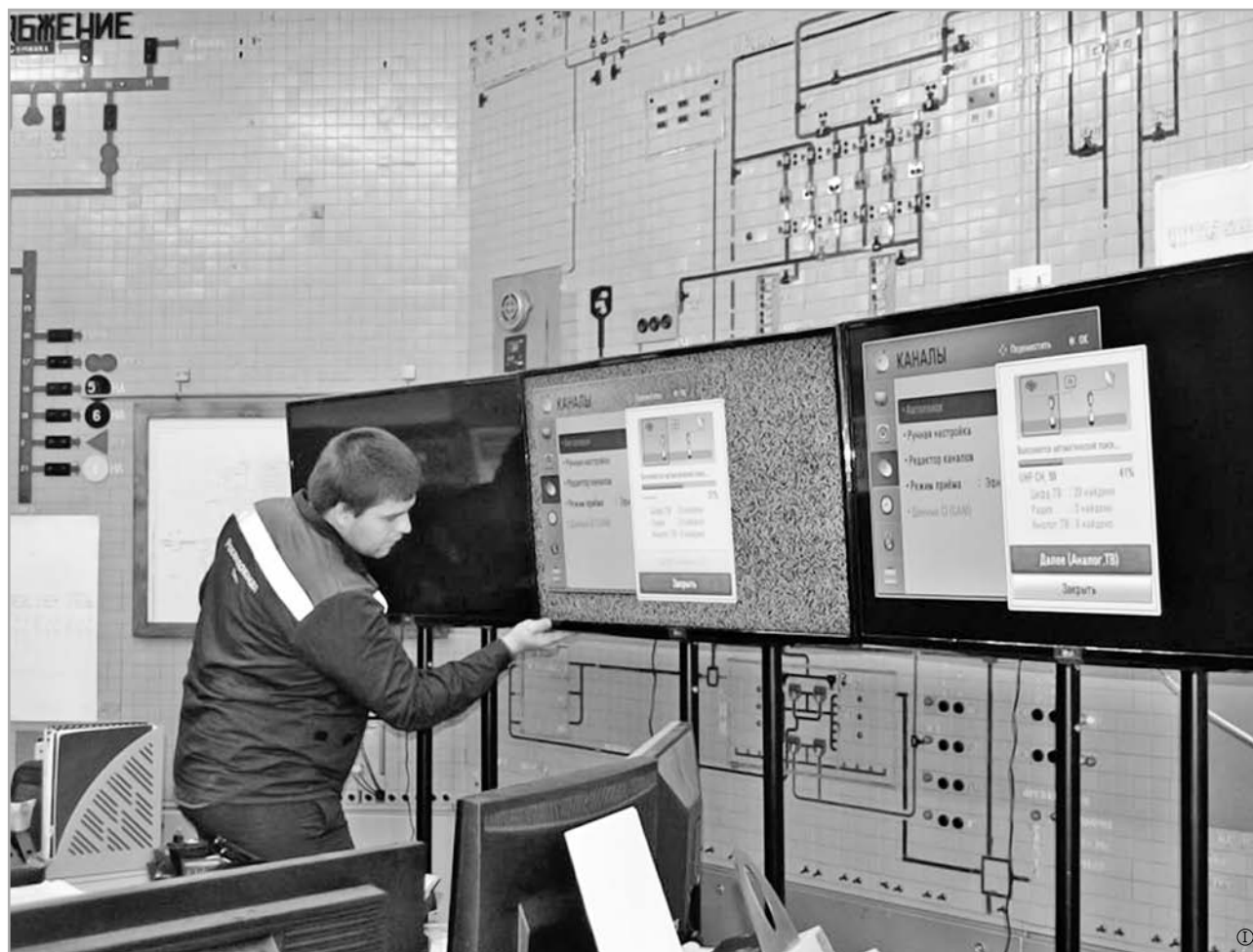
На мониторы будет выводиться информация о работе скважин, насосной станции и данные диктующих точек
