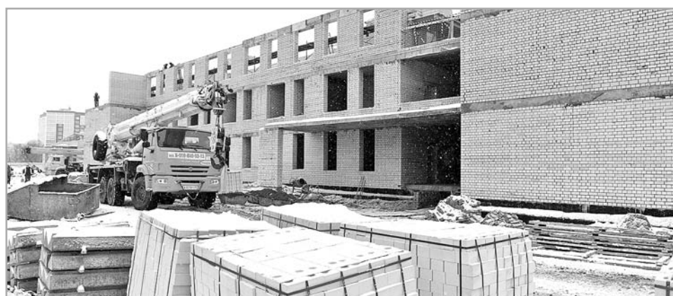
Строительство детской поликлиники в микрорайоне Южный
