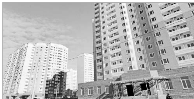
В стадии достройки в Тверской области остаются еще семь объектов СУ-155. Работы на этих площадках идут в соответствии с утвержденными графиками
