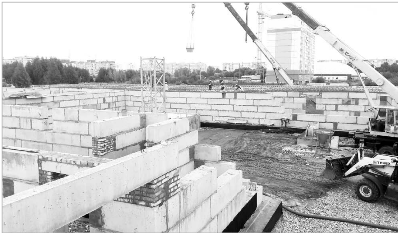
В микрорайоне Юность областного центра начато строительство школы с дошкольными группами на 560 ученических и 80 детских мест
