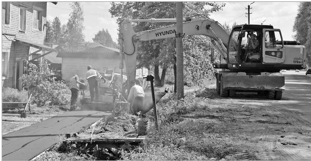
Оленино. Ремонт тротуара на улице Кузьмина – от парка до улицы Школьной
