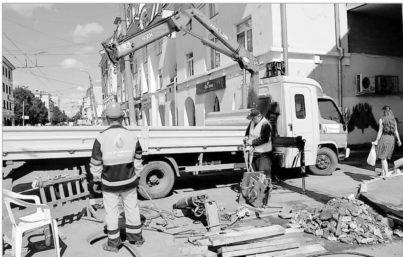
В условиях ограниченного роста тарифа ООО «Тверь Водоканал» старается выполнить максимальный объем работ, необходимых для обеспечения надежного водоснабжения и водоотведения города
