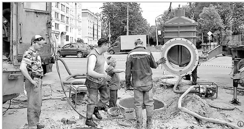
Замена задвижек на трубах большого диаметра
