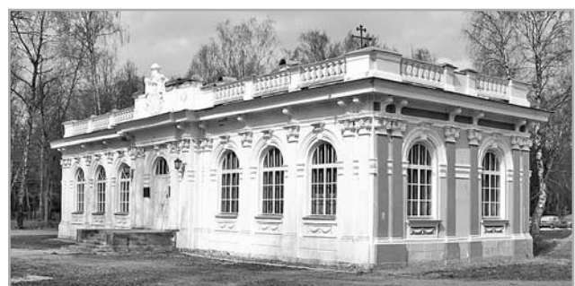
Церковь-усыпальница И.В. Гурко в Сахарове. Современный вид
