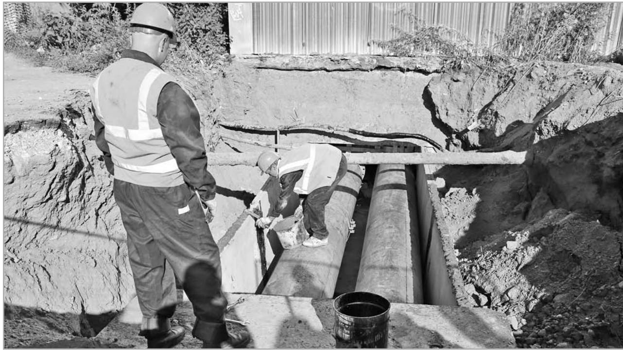
Пока идет ремонт, «Тверская генерация» должна смонтировать обводные линии, а по завершении работ наладить постоянный режим отопления
