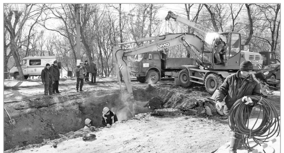
Ремонтные работы на теплотрассе по улице Новоторжской наконец-то завершаются
