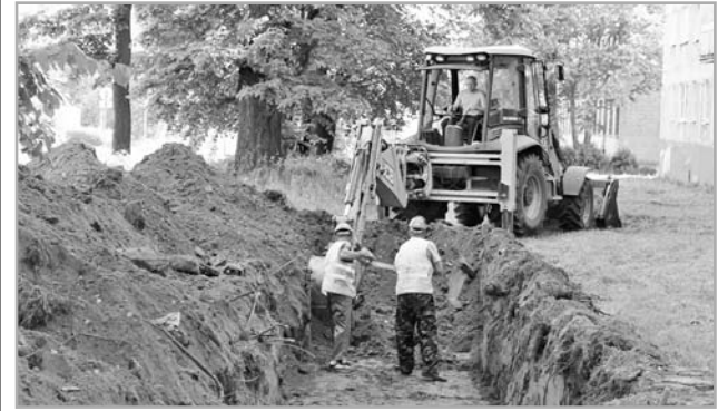
В Твери до осени отремонтируют 87 участков муниципальных теплосетей
