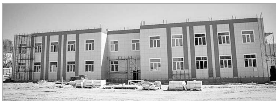
В Лихославльском районе Тверской области в рамках реализации нацпроекта «Демография» строится новый детский сад на 110 мест
