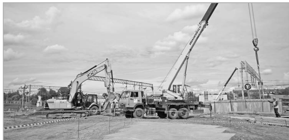
Реконструкция путепровода в Вышнем Волочке обойдется в 709 млн рублей
