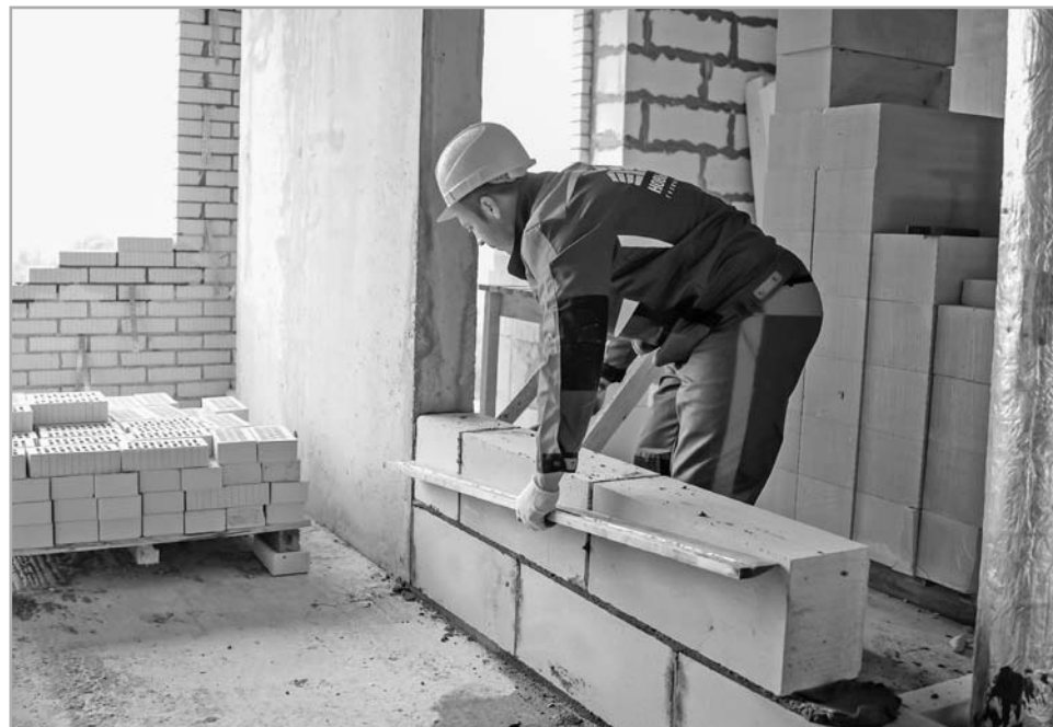
Мастерство строителей оценивают новоселы
