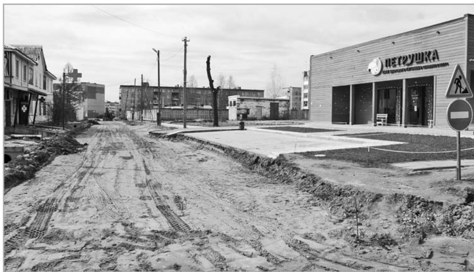
Ремонт пер. Куйбышева
