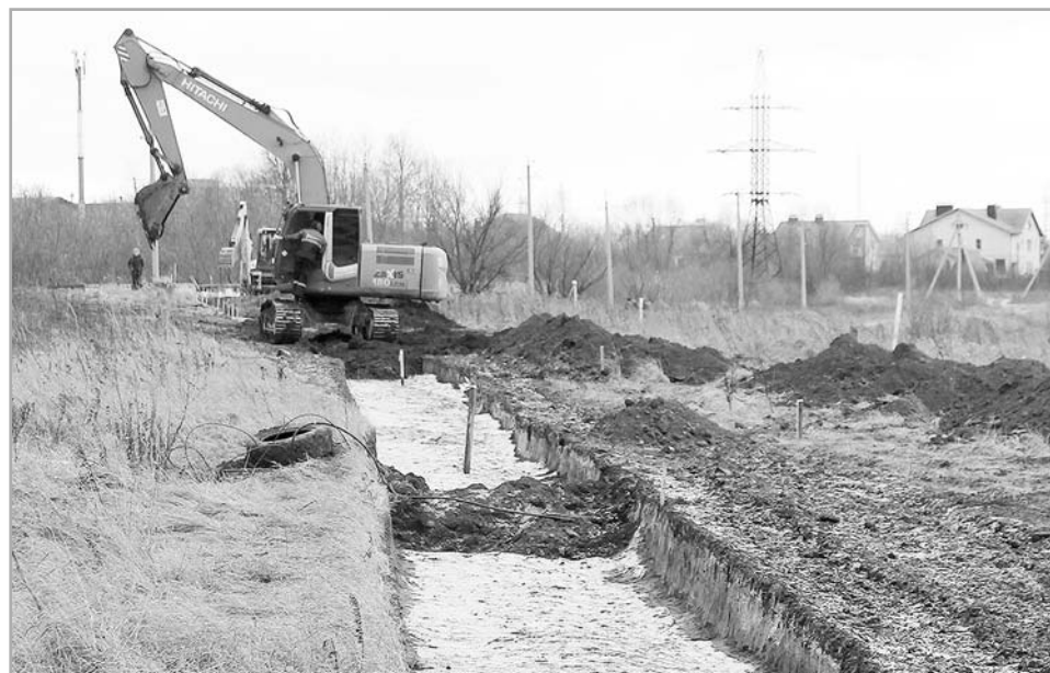
Реконструкция водовода от Тверецкого водозабора до дюзера Восточного моста началась в районе Новое Глазково с подготовительных и археологических работ
