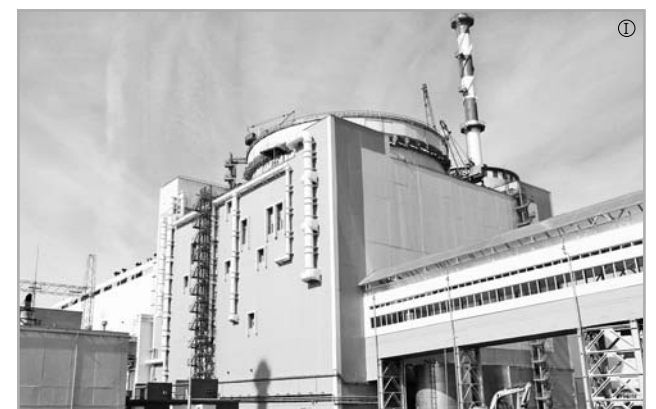
На энергоблоке № 4 атомной станции осуществлен запуск нейтринного детектора DANSS
