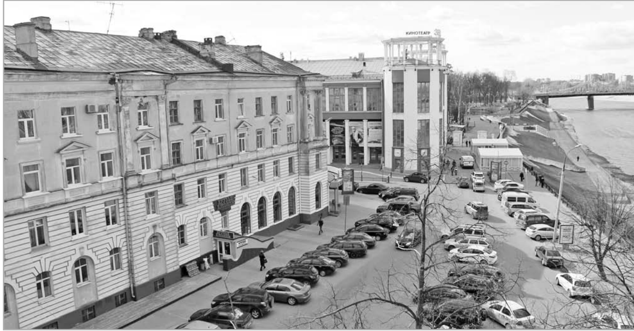
В администрации Твери намерены завершить все работы по ремонту фасадов на протяжении строительного сезона 2016 года
