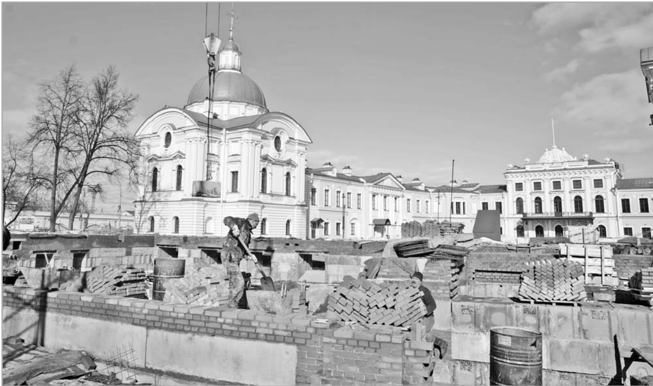
В восстановлении главного храма Тверской земли – Спасо-Преображенского собора – завершён нулевой цикл строительства, и сейчас уже начато возведение стен
