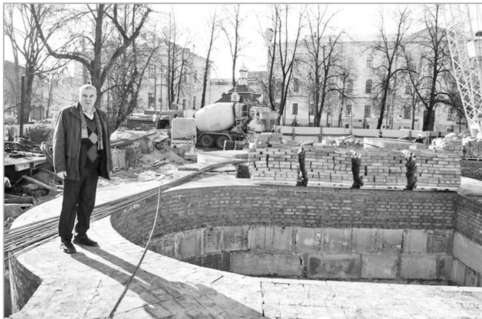
Уже нынешней весной строители, воссоздающие собор, намерены приступить к возведению стен
