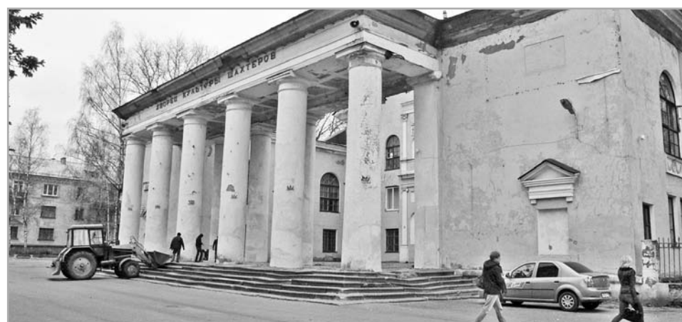
По поручению губернатора ДК «Шахтер» будет передан в областную собственность. В следующем году за счет областных средств должна начаться реконструкция
