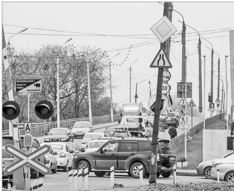
Капитальный ремонт Горбатого моста начался, и он скоро станет и более удобным, и более безопасным
