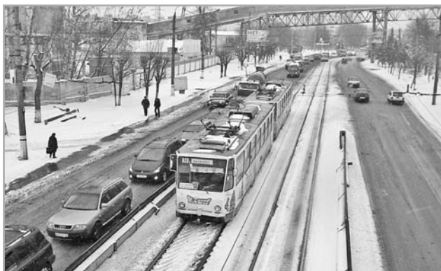
Демонтаж трамвайных путей перед железнодорожным путепроводом позволит облегчить движение автотранспорта и избежать пробок
