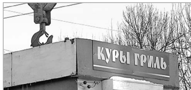
В Твери уже демонтировано около 450 нестационарных торговых объектов
