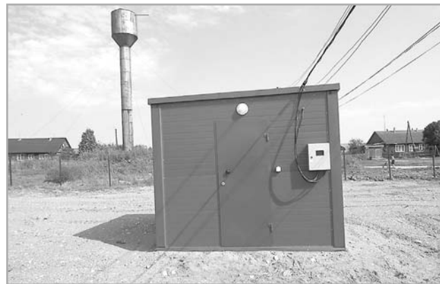
Ремонт предполагает замену павильона насосной станции, оборудования и глубинных труб
