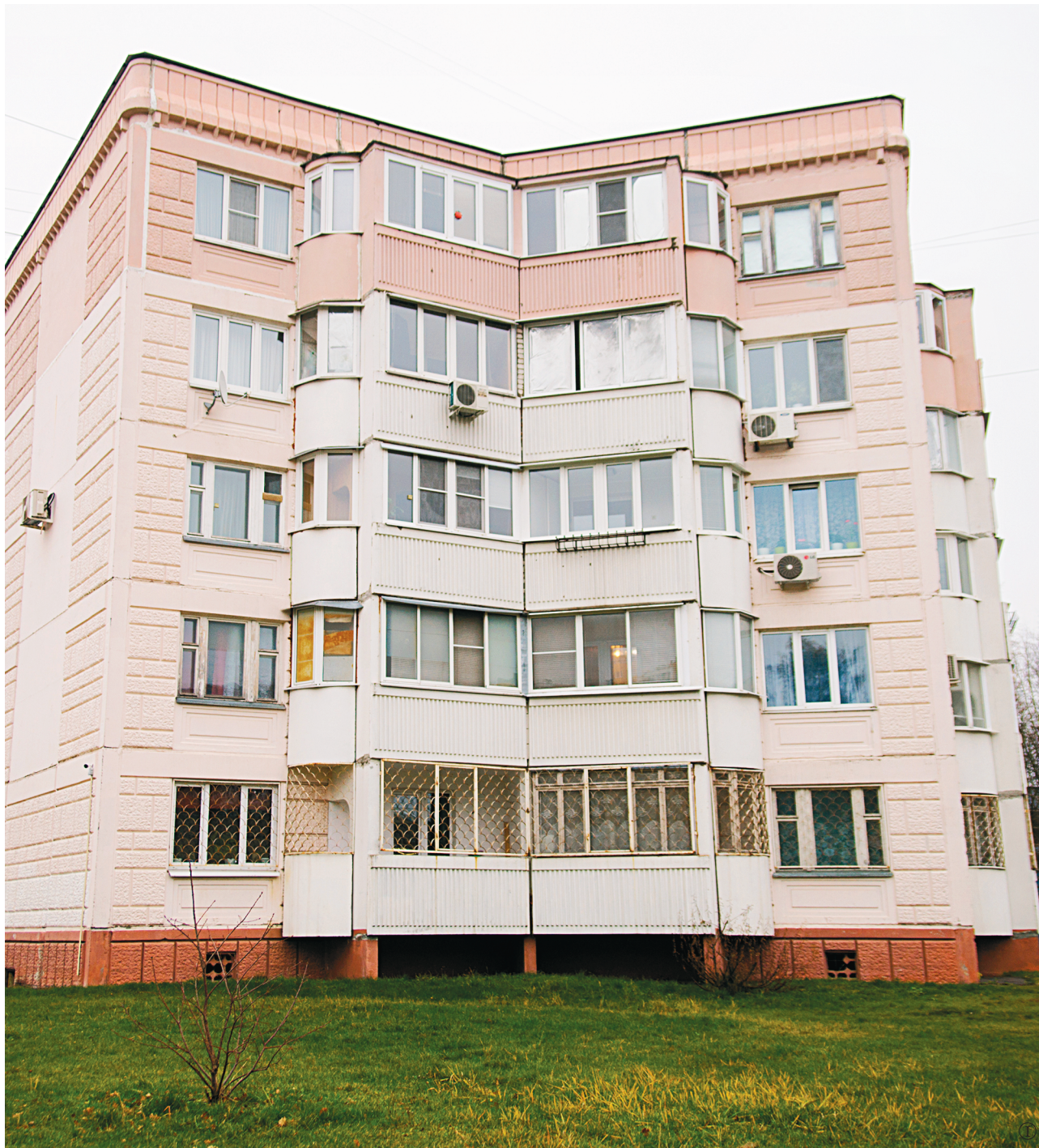
Дом на улице Артюхиной, в котором установлена система солнечного электроснабжения
