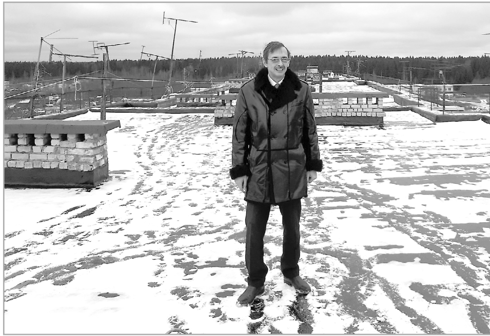
Глава Оленинского района Олег Дубов высоко оценил качество проведенных кровельных работ
