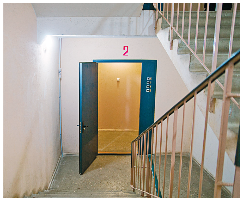
В подъездах установлена система освещения с датчиком, реагирующим на движение
