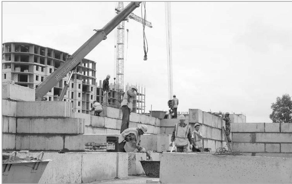
Темпы строительства новой школы в микрорайоне Юность набирают обороты
