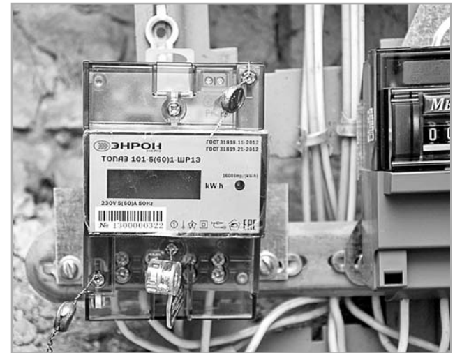
Установлен однотарифный счетчик «Топаз» с электронным табло – надежный продукт отечественного производства от завода-изготовителя «Энрон Энерго»
