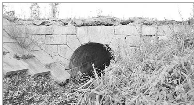
Каменный мост на шоссе Москва – Петербург на выезде из Твери. 1848 год
