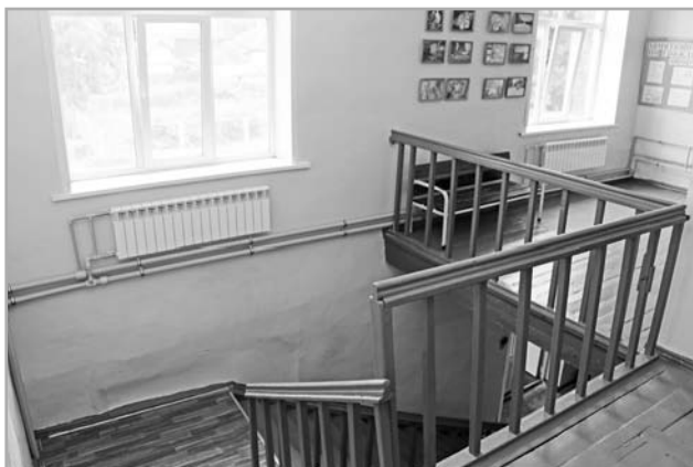
В торопецкой школе № 3 были проведены работы по устройству системы центрального отопления
