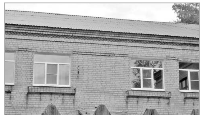
В прошлом году средства были найдены и ремонт крыши состоялся
