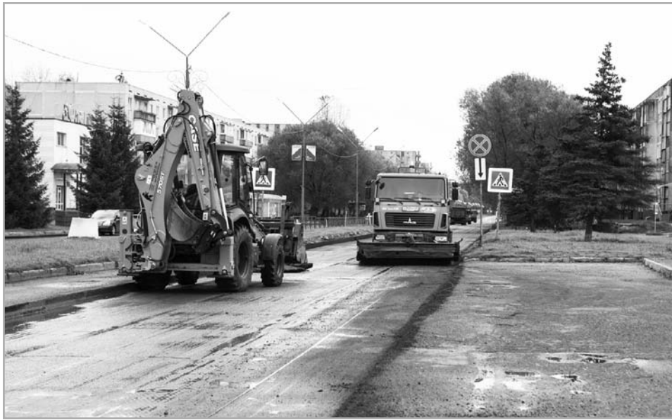
На проспекте Курчатова в Удомле уже укладывают асфальт
