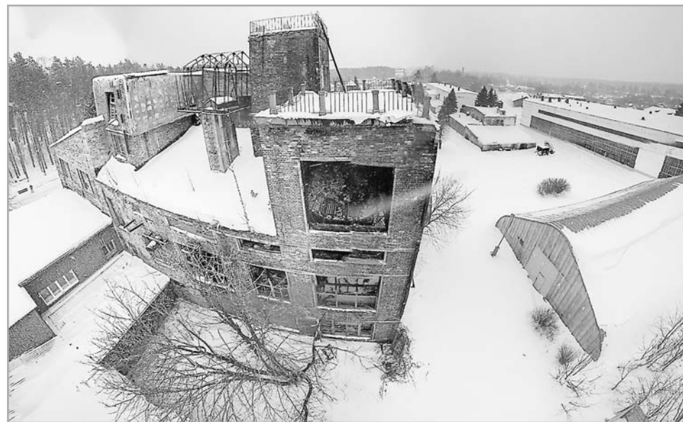
Так выглядит с квадрокоптера здание бывшего заводоуправления, построенное в 1920-х годах Н.Я. Колли
