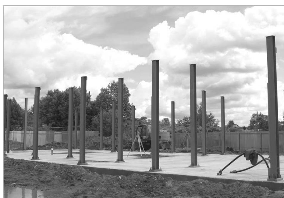
Строители уже поставили стальные колонны несущего каркаса будущей котельной
